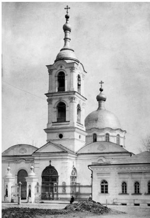
Петропавловская приходская церковь, г. Пенза. XIX в.
